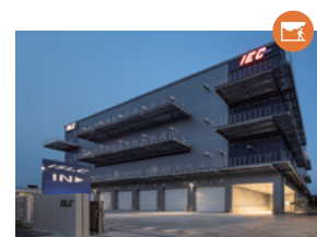
アイシーエクスプレス昭和島物流センター(SLC)新築工事 合理的な防災計画が実現できるよう当社でも初となる区画避難安全検証法を提案し、適用。
