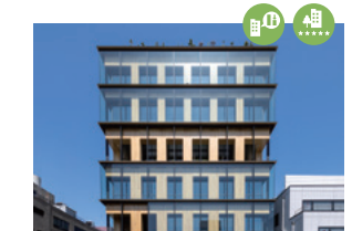
Port Plus 地上構造部材を木材とした高層純木造耐火建築物。CASBEE認証ランク、BELS認証、ZEB Ready取得。
