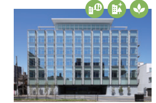
清水建設株式会社 東北支店新社屋 省エネルギー性に加え、数々の取組が高く評価。LEED® Platinum、BELS☆☆☆☆☆/Nearly ZEB
