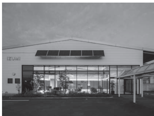
写真-1 外観写真
