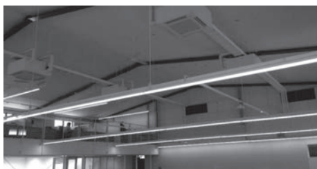
写真-6 改修前排煙口（パネル）
